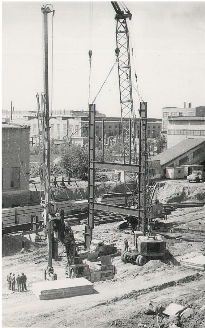
Рис. 3. Монтаж рамы в траншею при строительстве ПУ-8
