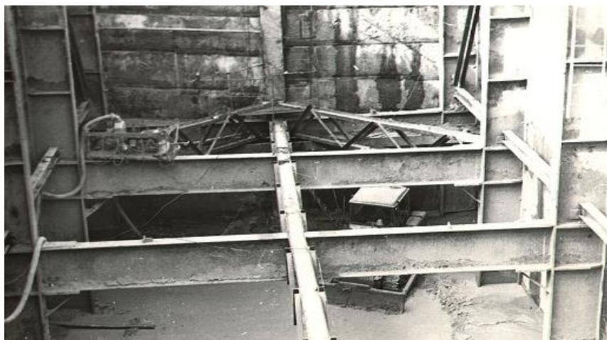
Рис. 4. Открытые рамы заглубленного сооружения перегрузочного узла № 8 со средним ригелем и временными распорками. Ниже бульдозер разрабатывает грунтовое ядро
